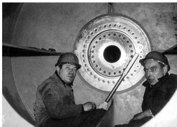
Fig.59 バケットホイールエキスカベータ シュパンリング RfN8006 580x630 によって中空軸とジャーナル軸受が締結されています。 Messrs. Fried. Krupp GmbH, Rheinhausen
