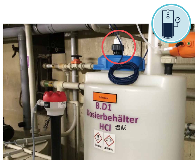
塩酸の充填量制御 : hps+80/I/GF/K5
